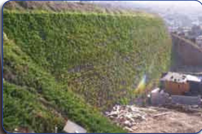
Sample retaining wall using whole tires Photo courtesy of La Comisión Estatal de Servicios Públicos de Tecate
