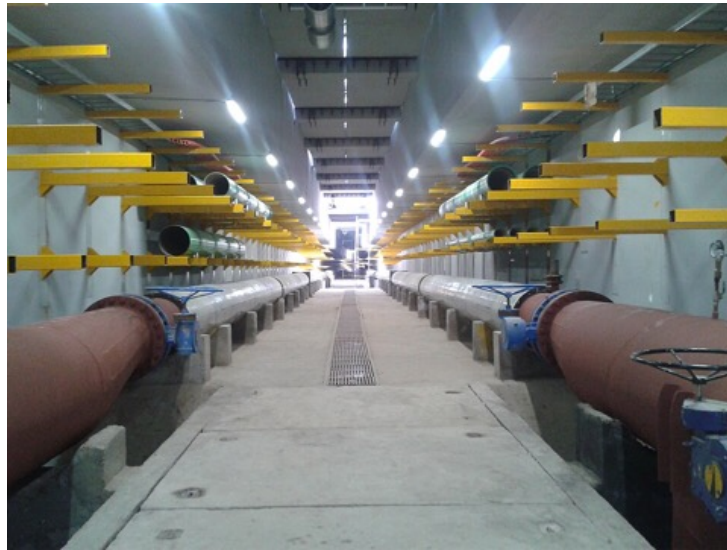
Utility Corridor (Atul Tegar, via Wikimedia Commons)
